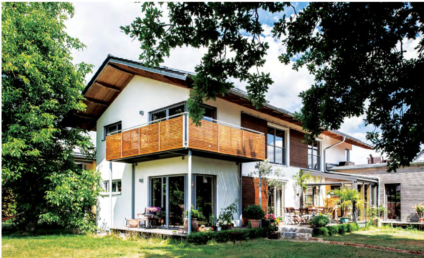
Nízkoenergetický rodinný dům – Německo, postavený stavebním systémem Thoma Holz100, s různorodými povrchovými úpravami vnějších svislých konstrukcí.
