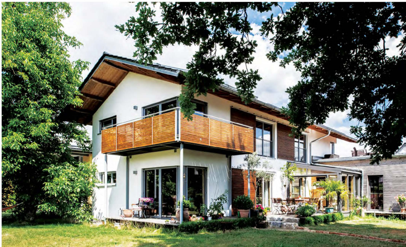
Nízkoenergetický rodinný dům postavený stavebním systémem Thoma Holz100, Německo s různorodými povrchovými úpravami vnějších svislých konstrukcí.
